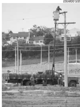
Construção está sendo realizada no Porto Seco
